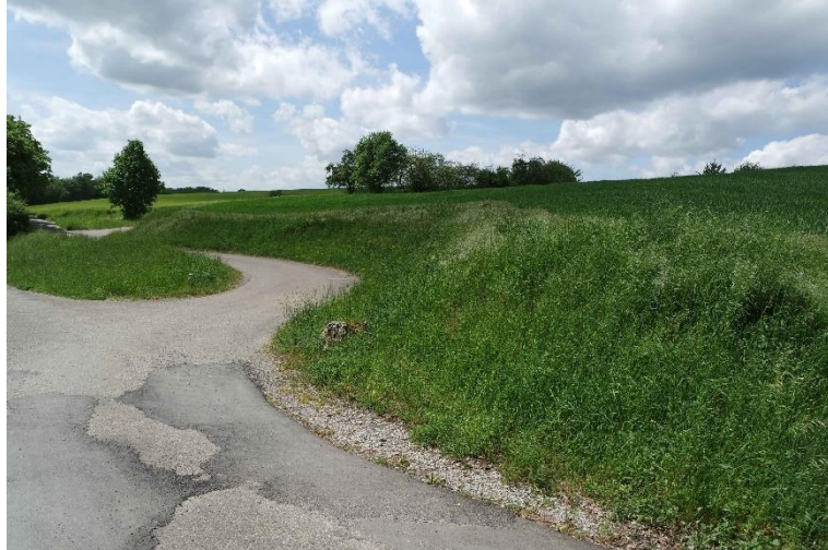
Abbildung 6: Blick auf das im Südosten des Geltungsbereichs angrenzende Rückhaltebecken (Foto © DNP, Mai 2022)
